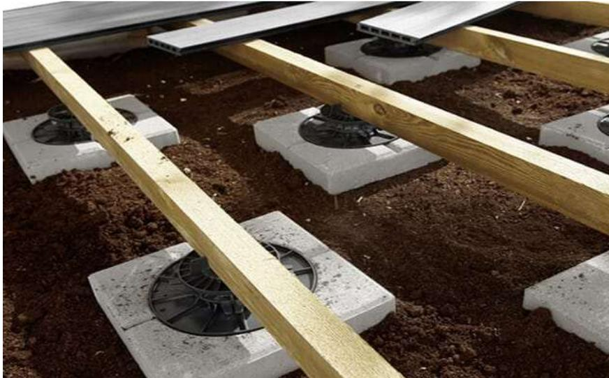
*Fondation en blocs bétons enterrés, supportant des charges plus importantes. Impacte les sols au niveau de chaque plot mais évite une dalle imperméabilisante sous toute la structure.*
