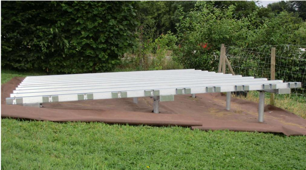
*Pieux enterrés, permettant d'adapter l'abri à la pente naturelle du terrain. Très faible impact sur le sol et évite un terrassement préalable. Permet le passage de la petite faune et la circulation de l'eau.*
