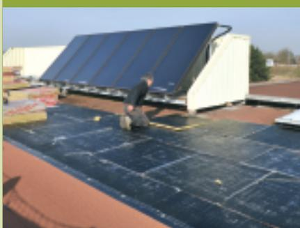
Amélioration de l'isolation et réfection de l'étanchéité sur le toit du Centre Technique Municipal.
