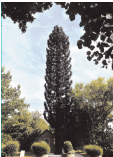
L'antenne relais de la Borne Blanche est dissimulé à l'intérieur d'un faux arbre.
