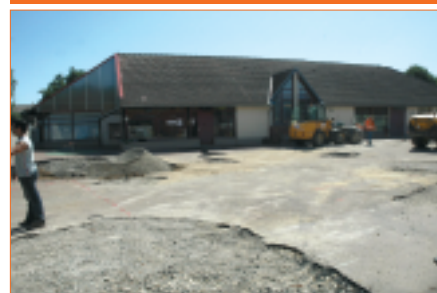
Restauration de la cour maternelle (128 000 euros)
