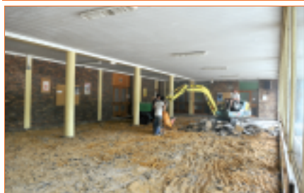
Création d'une dalle dans le préau couvert de l'école élémentaire pour la pose d'un revêtement de sol (36 000 euros)
