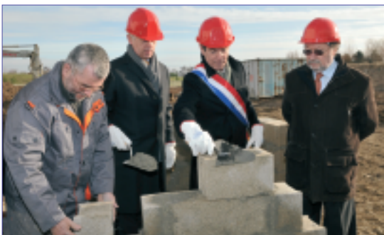
La première pierre du futur CEF a été posée le 22 janvier 2010.
