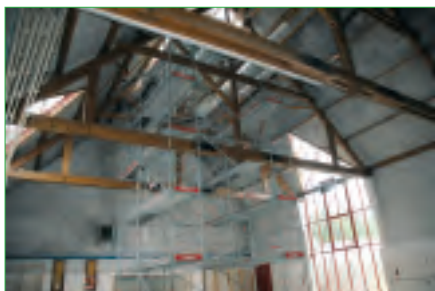
Groupe scolaire La Noue étanchéité et reprise de la verrière de la grande salle (coût : 175 000 euros / SAN)
