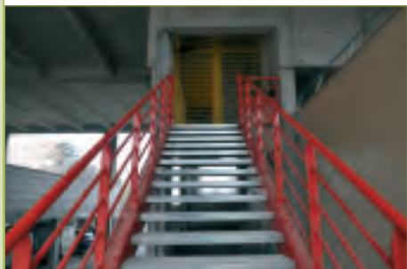
Les escaliers sont désormais sécurisés
