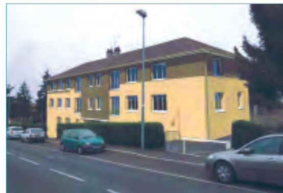
... une fois les travaux terminés.
