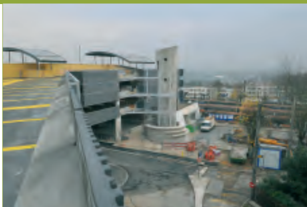
Le chantier de la gare vu du toit du parking
