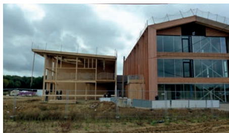
La future pépinière d'entreprises de l'Ecopôle
