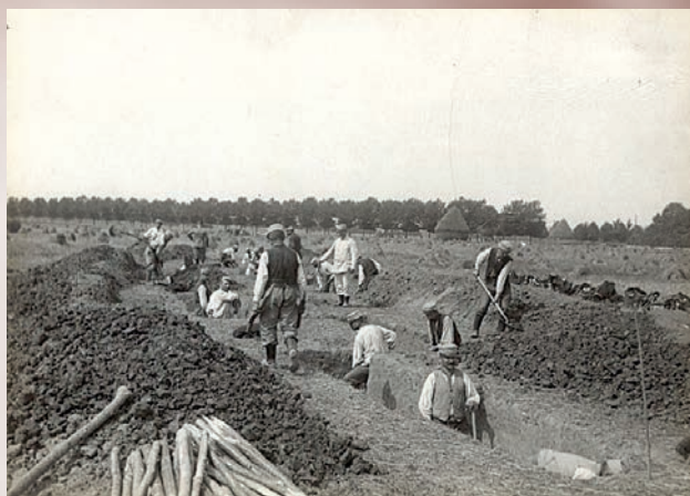
Creusement des tranchées de Tigery
