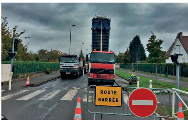
Durant les vacances de la Toussaint les rues Jean-François Millet, Jean Moulin et Pablo Picasso et le parking de l'entrée de la rue de la Thérouvanne ont été rénovés. Coût total : 250 000 euros
