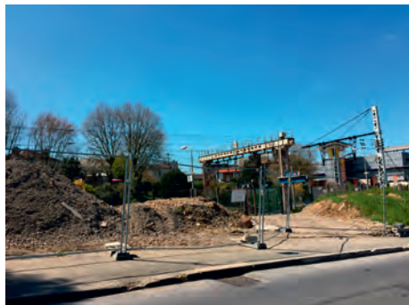
Travaux en cours
