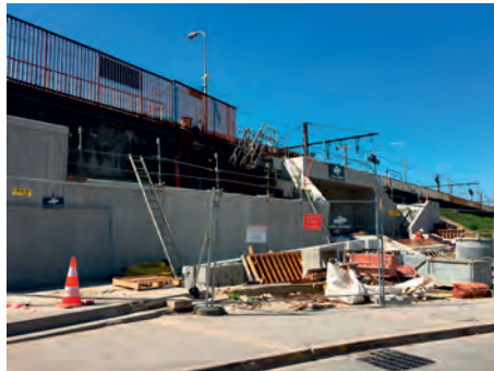
Travaux en cours
