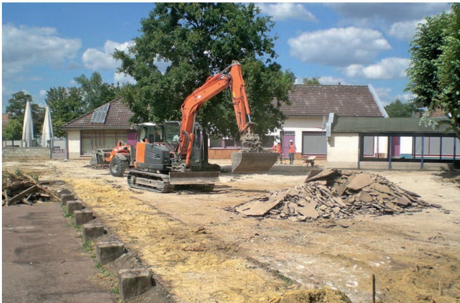
La cour de l'école la Tour d'Aleron totalement rénovée
